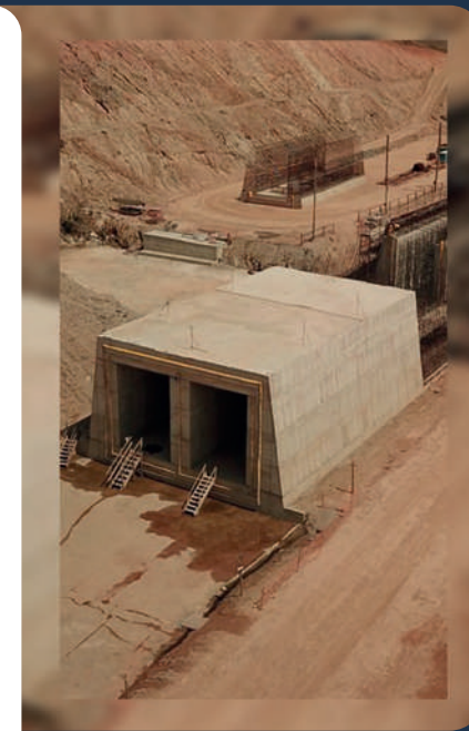
Galeria de desvio - Barragem Duas Pontes
