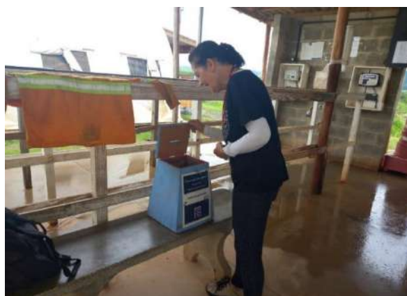
Foto 12 – Abertura da Caixa de Comunicação do Canteiro Duas Pontes (Data: 30/01/2023)
